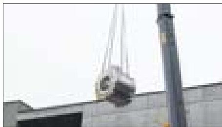
Am Haken eines Pneukrans schwebt der Magnetresonanztomograf an die richtige Stelle. zVg
